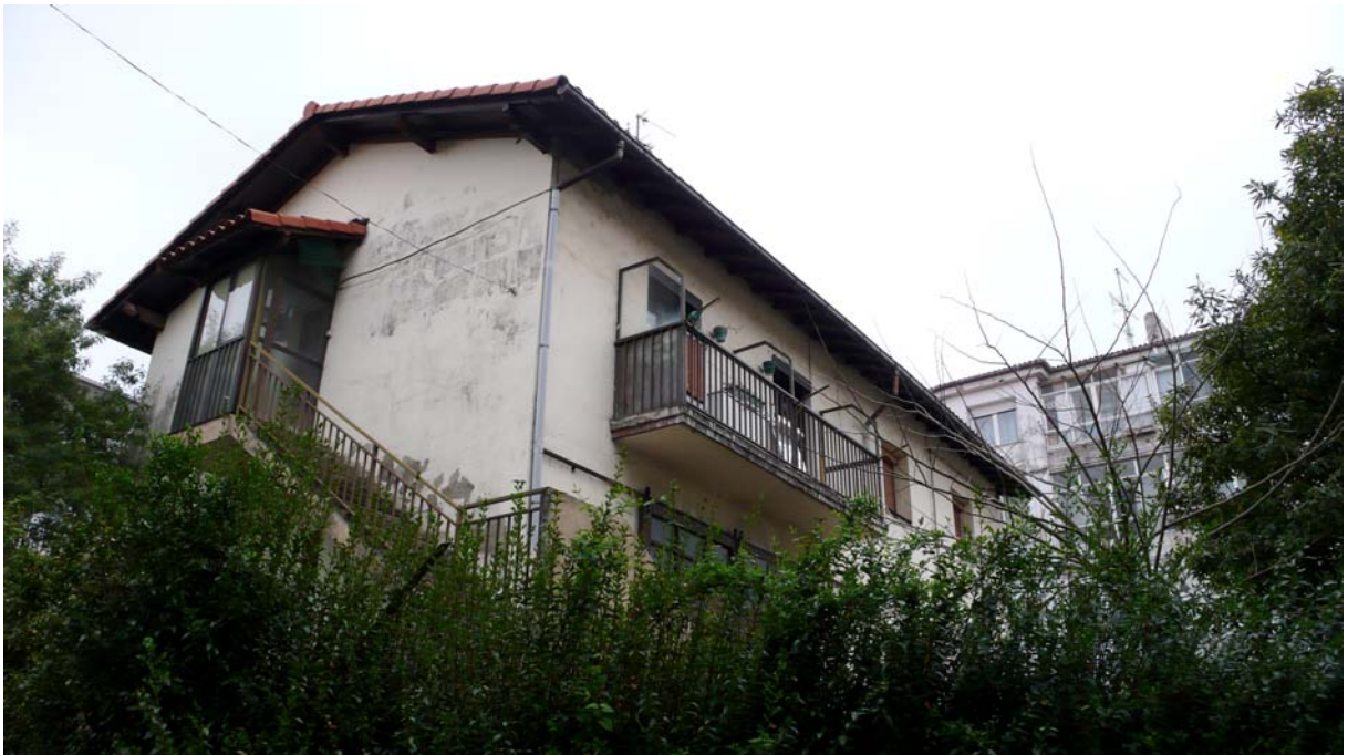
Vista desde la calle Curtidores.
