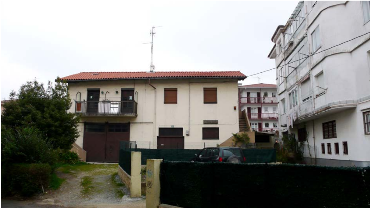
Vista desde la calle Curtidores.
